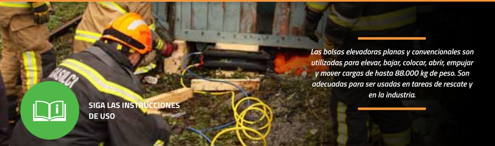
Las bolsas elevadoras planas y convencionales son utilizadas para elevar, bajar, colocar, abrir, empujar y mover cargas de hasta 88.000 kg de peso. Son adecuadas para ser usadas en tareas de rescate y en la industria.
